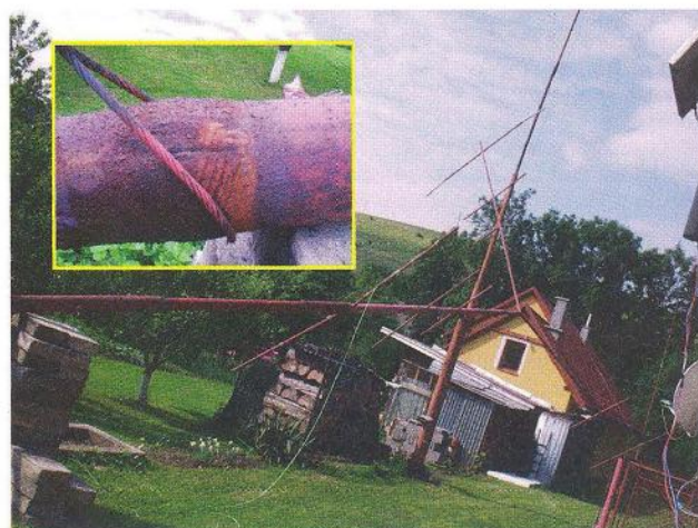
Obr. 11. A „blesková“ deštrukcia môjho anténneho stožiaru
